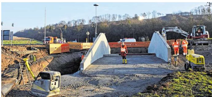
Unterhalb der „Kaserenkreuzung“ wird in den Schutzdeich eine sechs Meter breite Durchfahrtsmöglichkeit integriert. Diese kann bei Hochwasser mit mobilen Elementen verschlossen werden.
