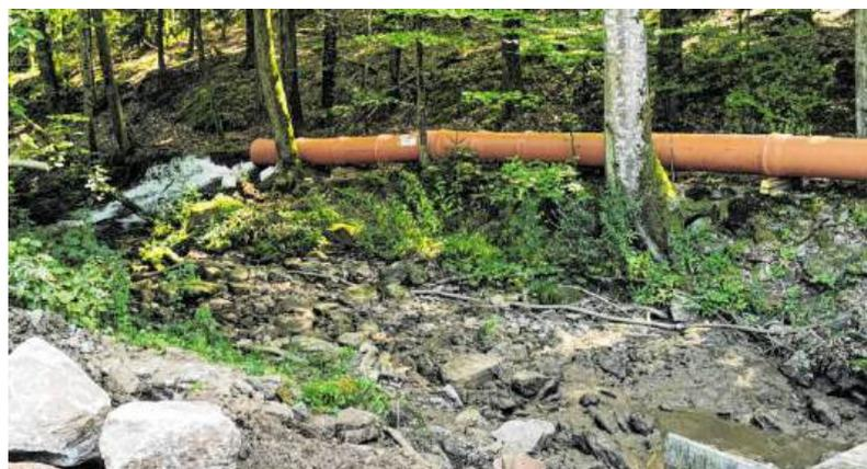
Der Bach wird für die Dauer der Bauarbeiten umgeleitet und über ein Rohr wieder in sein altes Flussbett „entlassen. Gut zu sehen ist auf dem rechten Bild noch die kleinere der beiden entstandenen Ausspülung hinter der zweiten Herdmauer.
